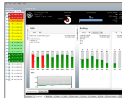
Salud y riesgo del transformador
